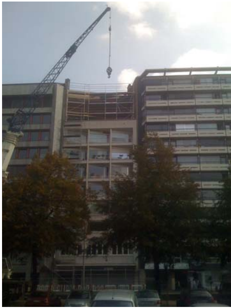
Illustration 7: La préfabrication permet de limiter le temps de montage. Cet avantage est prépondérant particulièrement en situation urbaine et lorsqu'on intervient sur un immeuble occupé, comme c'est le cas dans cet immeuble situé sur une artère fréquentée au centre de Liège . Architecte : Rudolph Stassen, Liège
