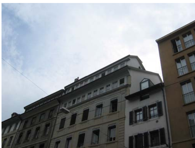
Illustration 3: Traces des surélévations dans le quartier St-Gervais à Genève
